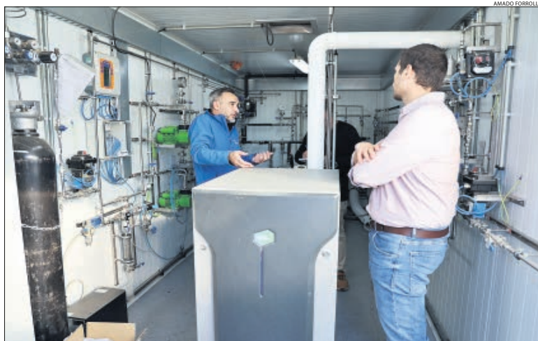
El prototipo de generador de electricidad a partir del hidrógeno destilado del biogás genera 36 kw/día.
