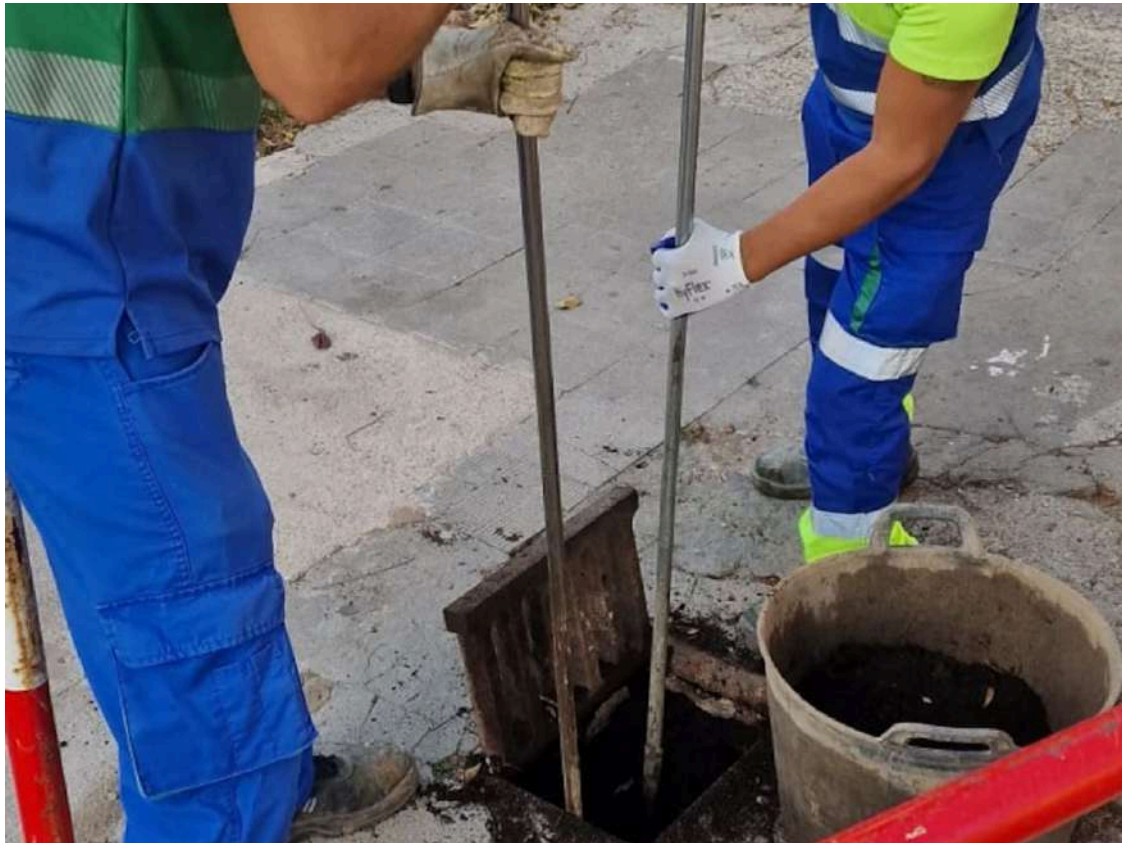
Trabajos en imbornales de La Línea / La Línea.es
