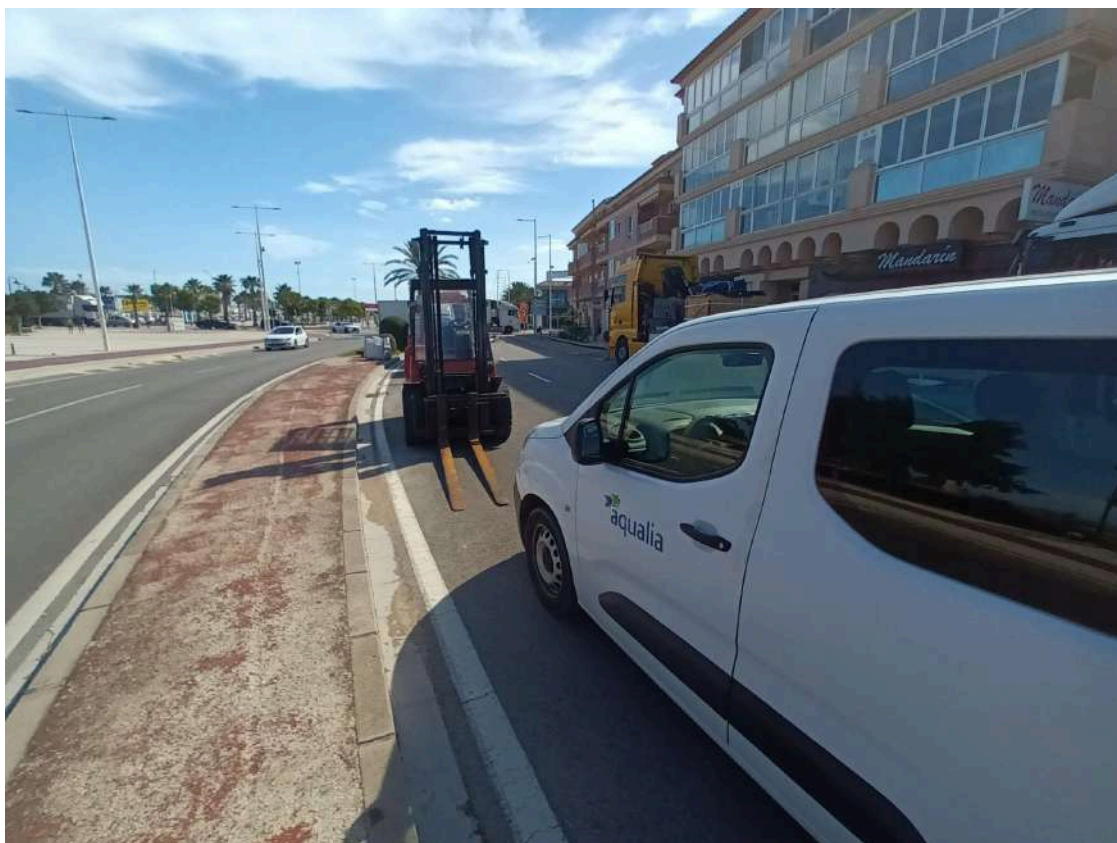
Obras de la segunda fase del colector en Cagarritar
