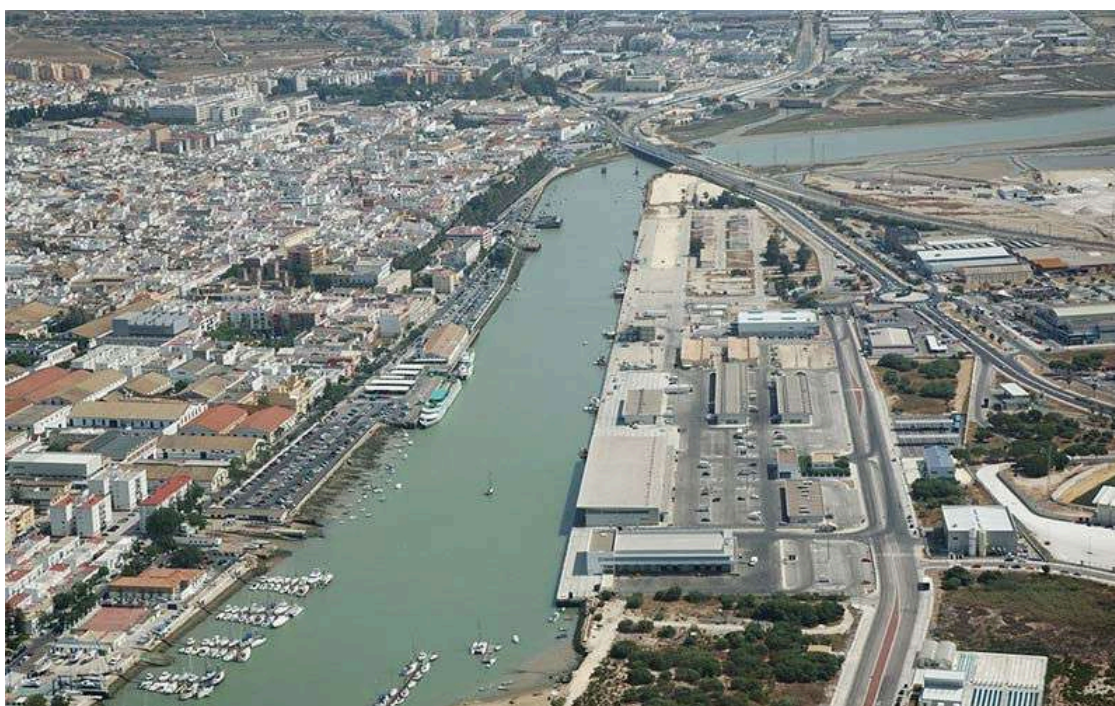
Vista aérea de parte de El Puerto / FOTO: Ayto.
