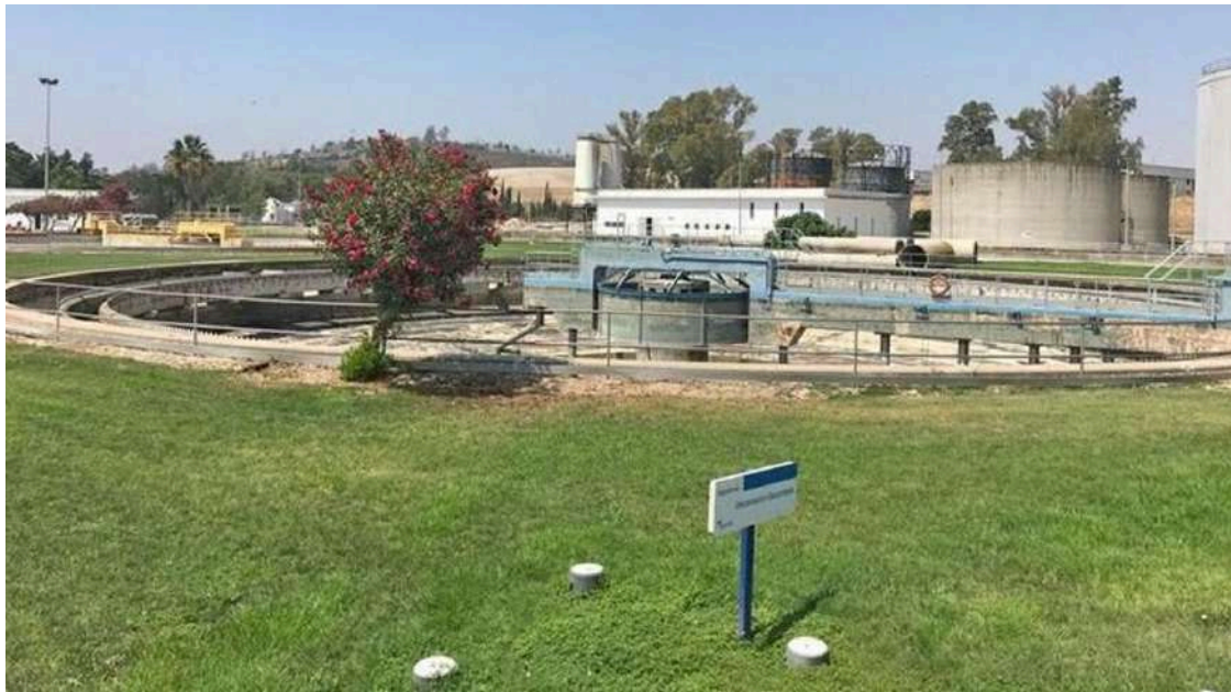
Una imagen de las instalaciones de la EDAR de Jerez.
