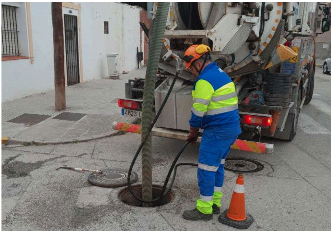
Un operario de Aqualia limpiando una alcantarilla en La Línea. La Línea refuerza la limpieza de imbornales para prevenir incidencias ante las lluvias de otoño
