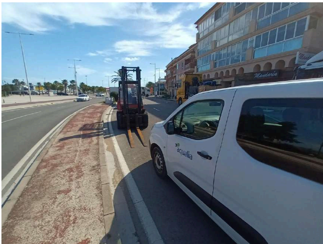
Obras de la segunda fase del colector Cagarritar / Ayuntamiento de Dénia
