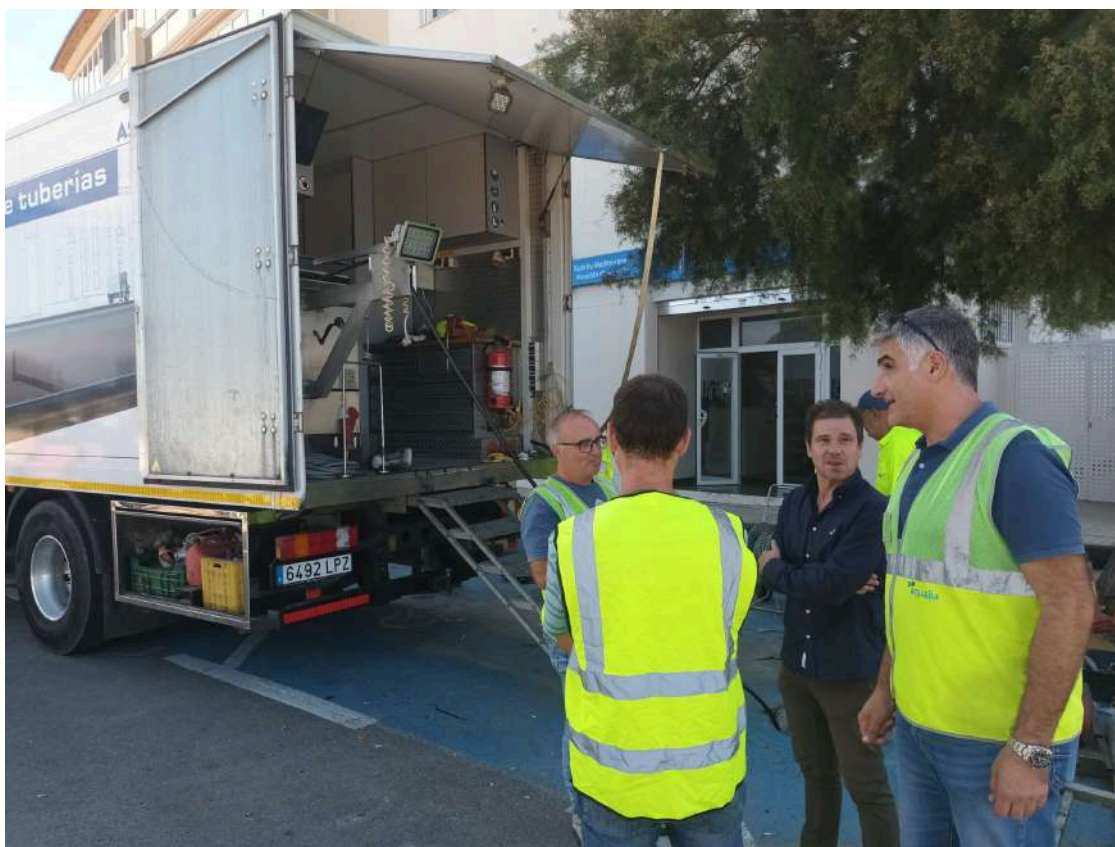
Obras de la segunda fase del colector Cagarritar en Dénia
